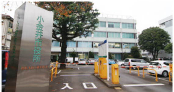
小金井市役所本庁舎
